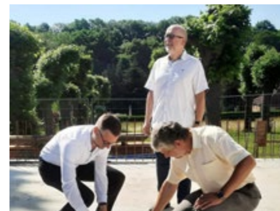
Versenkung der Zeitkapsel in der Bodenplatte des Neubaus der Gedenkstätte Großschweidnitz
