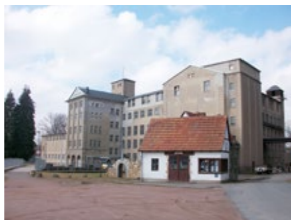
In der ehemaligen Spinnerei wurden die Häftlinge des frühen Konzentrationslagers Sachsenburg untergebracht.
