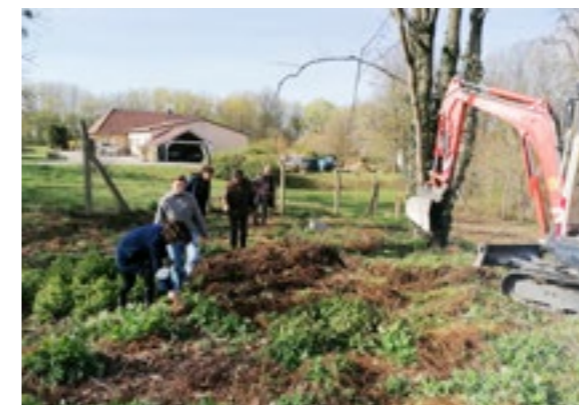
Probegrabung auf dem Gelände der ehemaligen Anstaltsdeponie in Pirna-Sonnenstein
